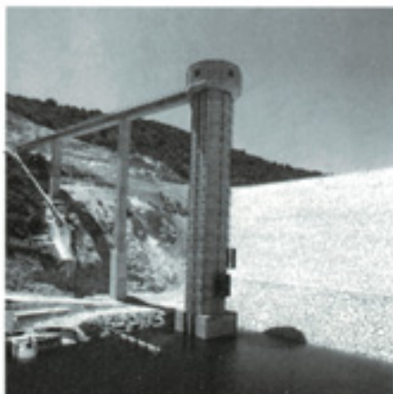
Pasarela de la Torre de Toma de la Presa de Guadalcacín, Cadiz
