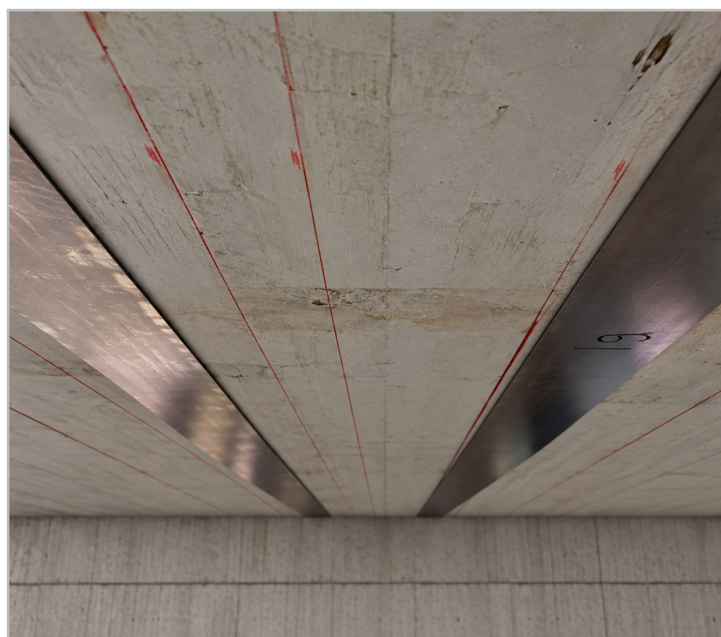
Renforcement d'une dalle par CMP-C
